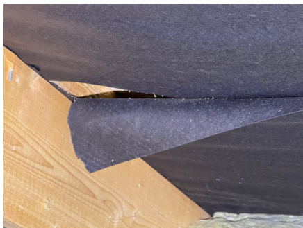
Utett undertaksduk/vindsperre
