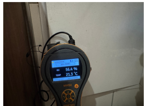
Måling av relativ luftfuktighet.
