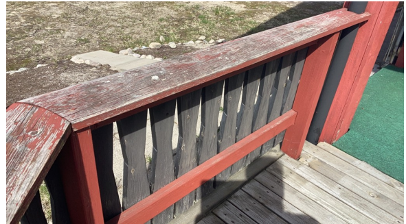
Eksempel på slitasje på hovedveranda.
