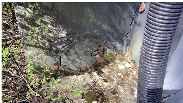
Sotluke på utvendig pipe.
