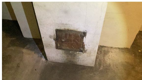
Sotluke i kjeller.
