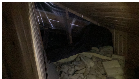
Bilde fra kor i 2. etasje.
