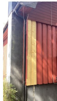
Utført utskifting av kledningsbord.
