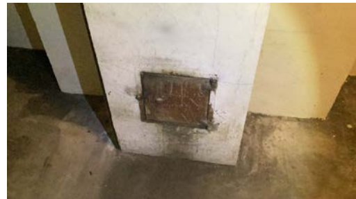
Sotluke i kjeller.
