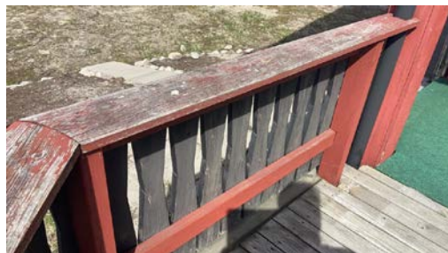
Eksempel på slitasje på hovedveranda.
