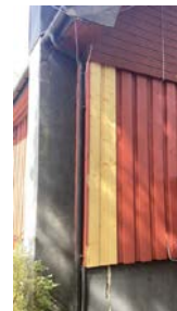
Utført utskifting av kledningsbord.
