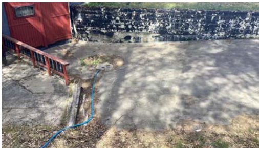
Fall på terreng inn mot bygget.
