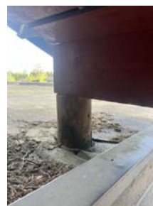
Tak over veranda ved entre er fundamentert på takflate på garasje.
