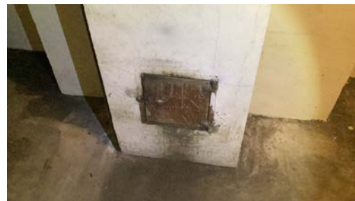
Sotluke i kjeller.
