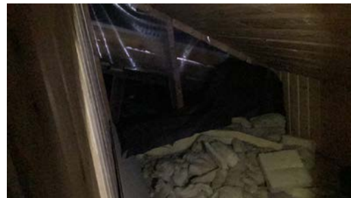
Bilde fra kor i 2. etasje.
