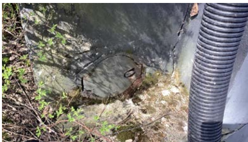
Sotluke på utvendig pipe.
