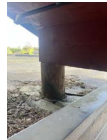
Tak over veranda ved entre er fundamentert på takflate på garasje.
