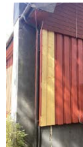
Utført utskifting av kledningsbord.
