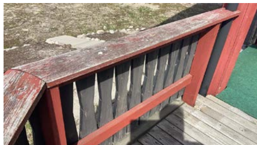
Eksempel på slitasje på hovedveranda.
