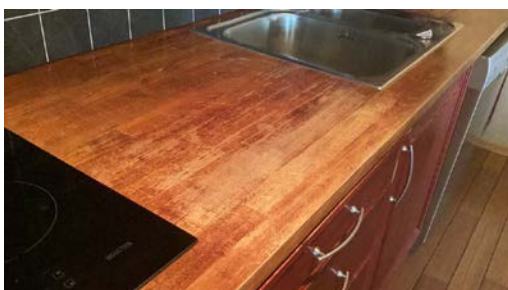
Eksempel på slitasje.
