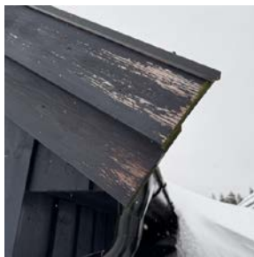
Værslitt vindskibord sørvegg
