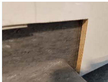
Uferdig montering i nedkant av veggplater
