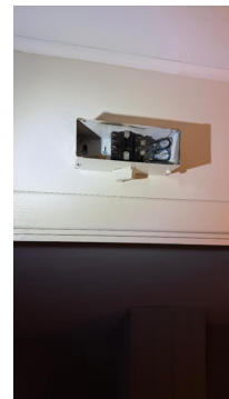
Mangler deksel på stråleovn loft.
