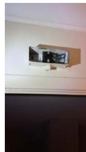
Mangler deksel på stråleovn loft.
