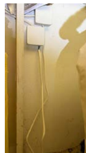
Mangler deksel på stråleovn loft.
