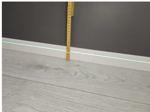
Etasjeskillet er kontrollert med nivelleringslaser.
