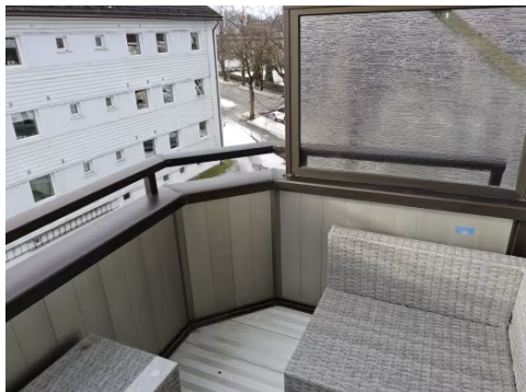
Balkong i metallkonstruksjoner.
