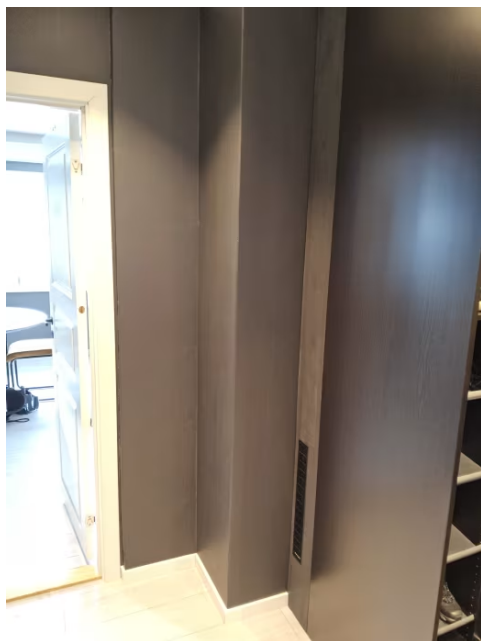
Deler av pipen er innbygd i garderoben på soverommet.
