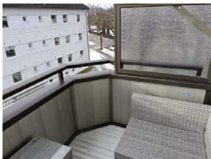
Balkong i metallkonstruksjoner.
