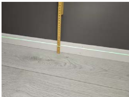
Etasjeskillet er kontrollert med nivelleringslaser.
