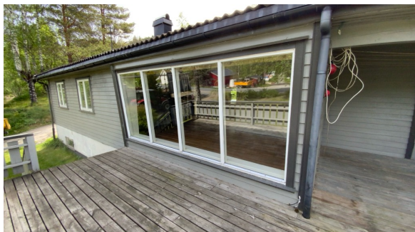
Store stuevinduer fra 1993.
