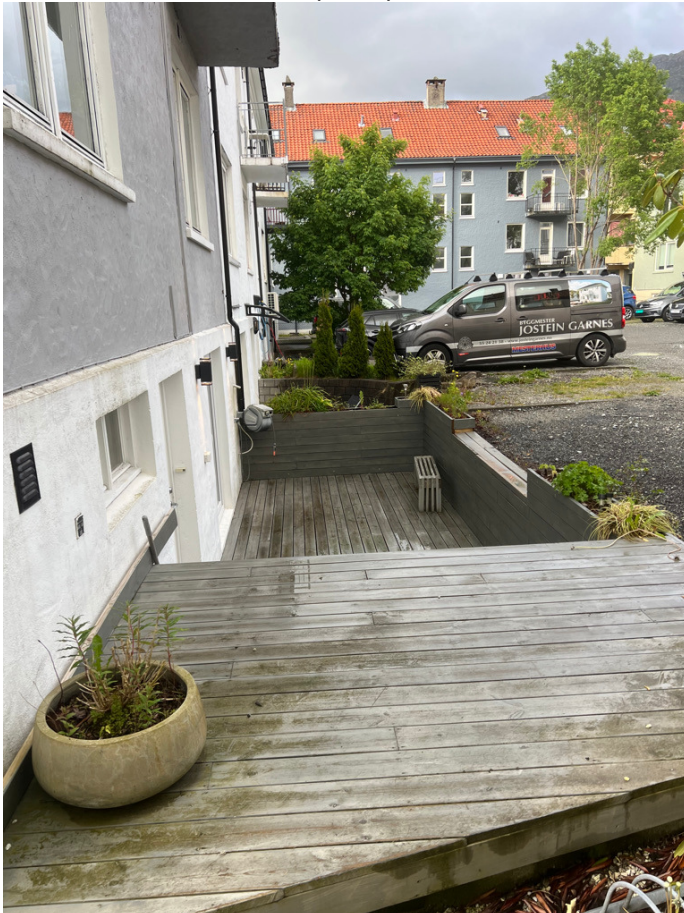
Mot nord – viser øverste platå på terrassen
