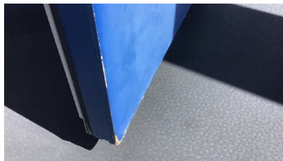
slitasje/bruks merker i nedkant
