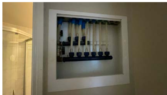
Besiktigelse av røropplegg.
