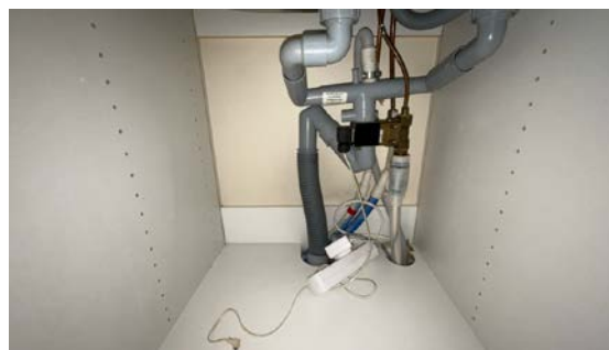
Besiktigelse av røropplegg.
