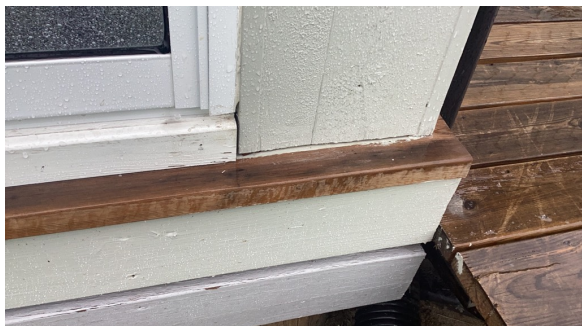
Eksempel på løsnign utsatt for fuktpåkjeni
