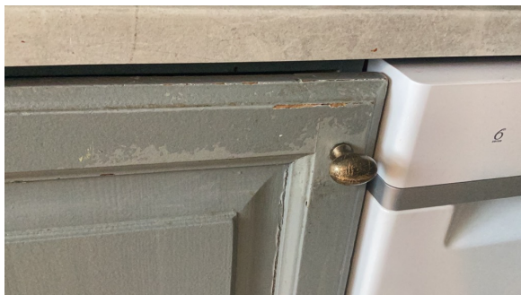
Eksempel på slitasje.
