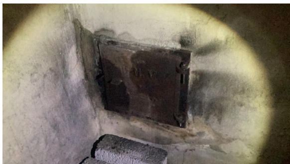
Sotluke i kjeller.
