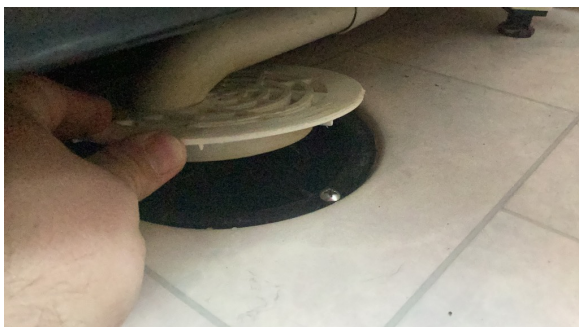
Sluk av plast med klemring.
