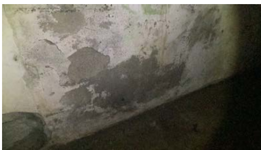
Eksempel på overflater med fuktpåkjenninger.
