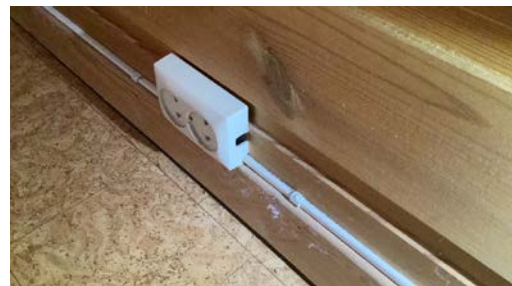
Eksempel på forhold som ville gitt avvik ved en el-kontroll.
