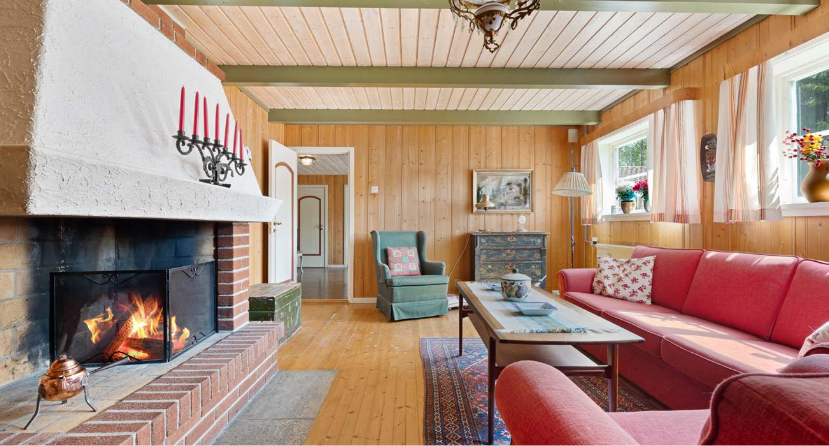
Rommet har furugulv, panelvegger, hvitlasert paneltak og synlige, malte takbjelker.
