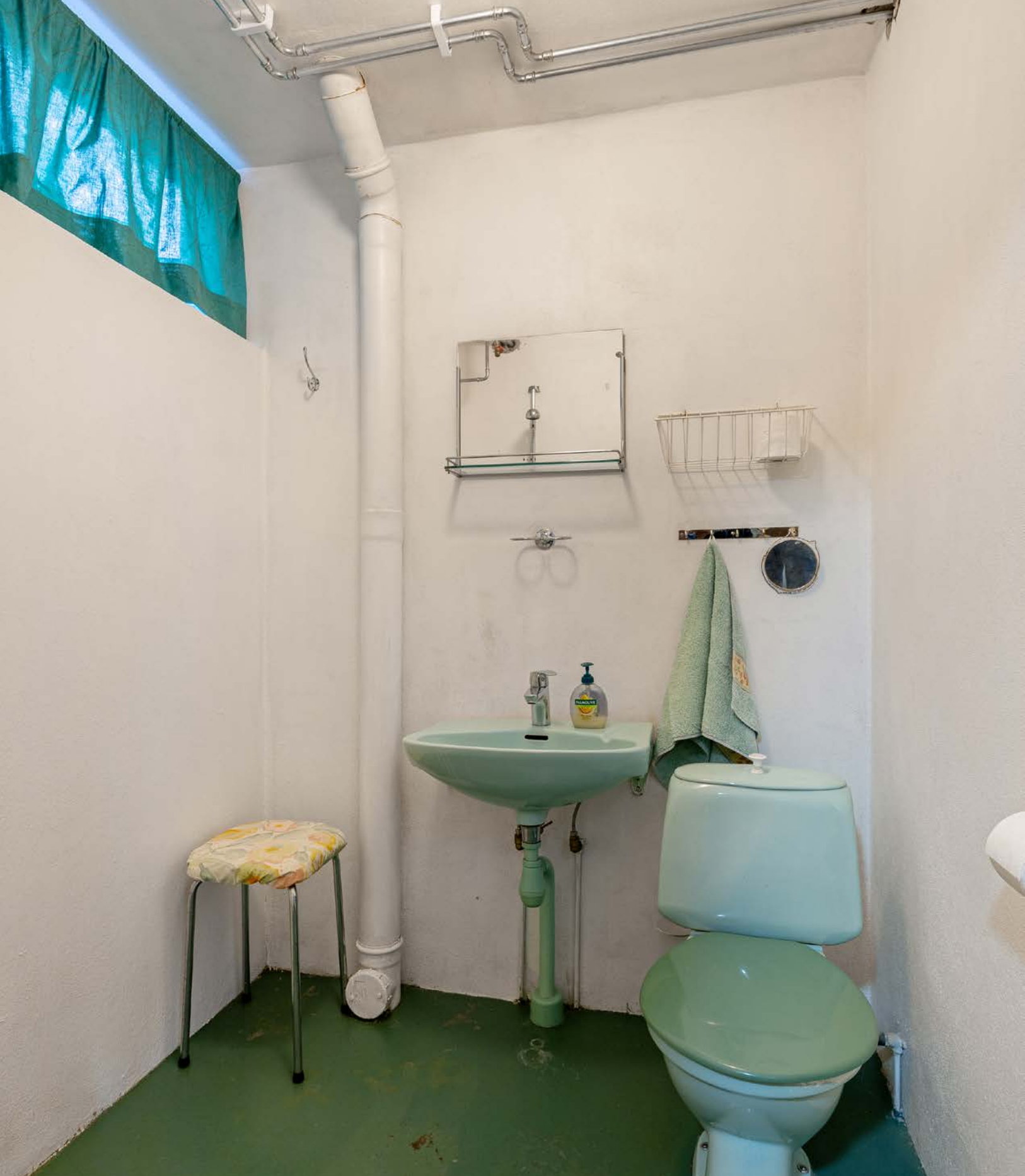
Det er bad i hver etasje. Badet i underetasjen har malt betonggulv og malte murvegger.
