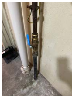
Stoppekran funksjonstestet ok.
