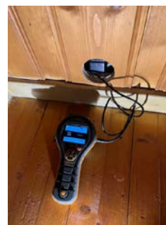
Fuktmåling i utforet vegg mot terreng, viste ingen utslag.
