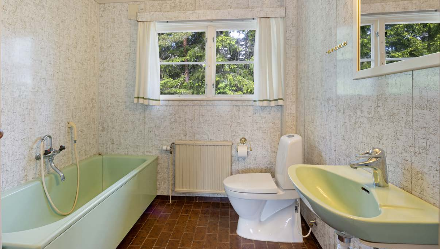
Badet i første etasje har mørke fliser på gulvet og lyse baderomsplater på veggene. Oppvarming er både med gulvvarme og via radiator.
