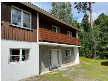
Balkong med nytt rekkverk og utbedret dekke.
