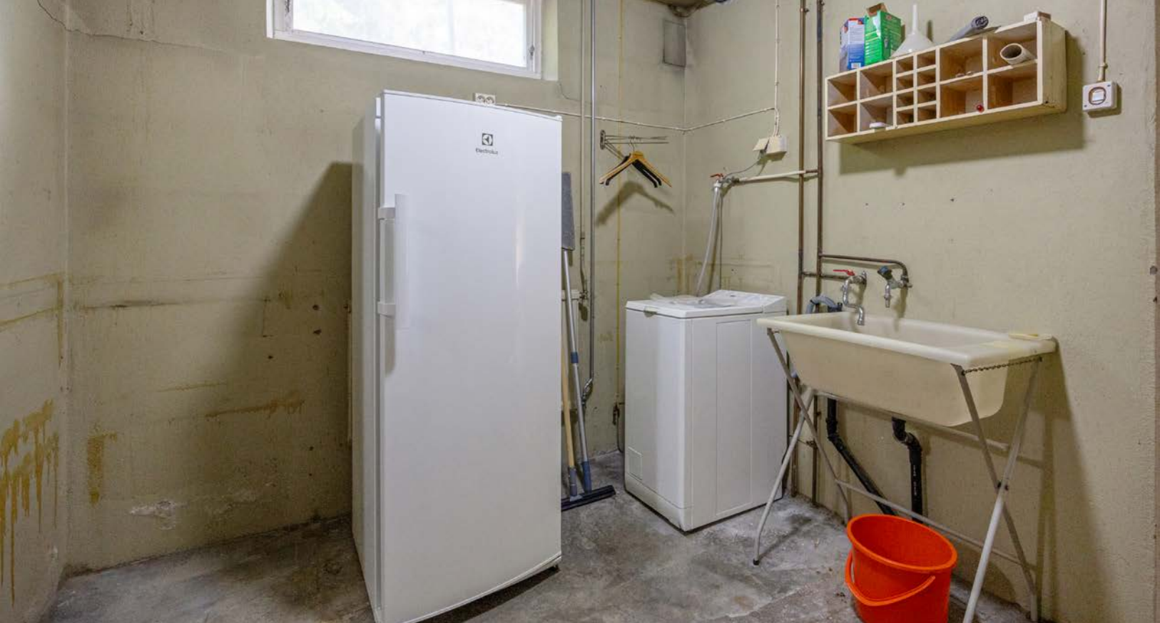
Vaskerommet ligger også i underetasjen og har malt betonggulv, malte murvegger, varmesentral, skyllekum og opplegg for vaskemaskin.
