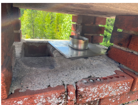
Pipe med stålrør og luftekanal.
