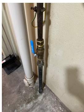
Stoppekran funksjonstestet ok.
