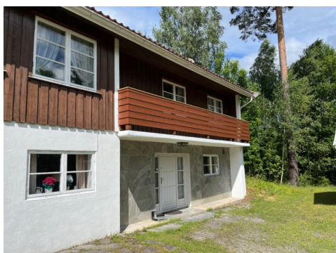
Balkong med nytt rekkverk og utbedret dekke.
