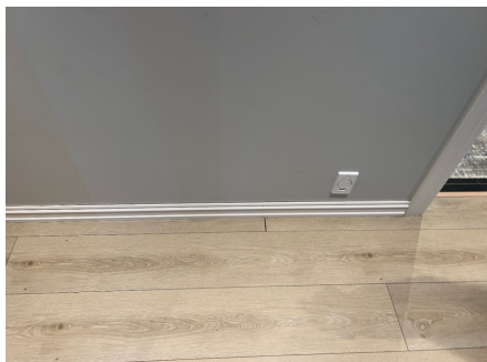
Stuegulv - ved trapp - mot baderomsvegg.
