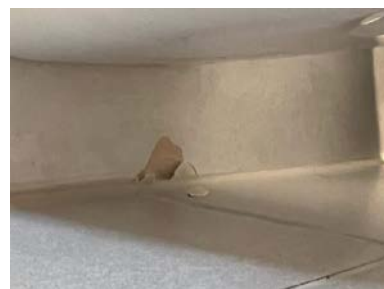
Veggflis under veggmontert toalett.
