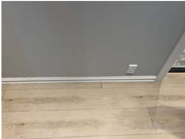
Stuegulv - ved trapp - mot baderomsvegg.
