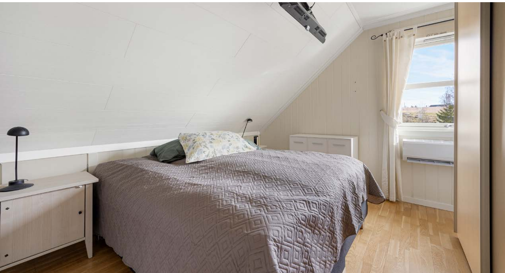
Hovedsoverommet har installert luft-til-luft varmepumpe, installert i 2016.
