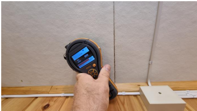
Fuktmåling i himling i bod i tilbygget del.
