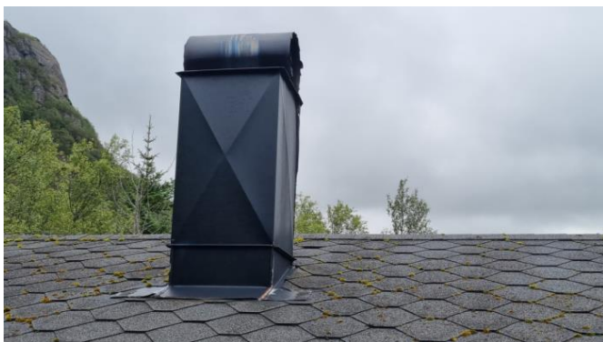
Kontroll av pipebeslag.
