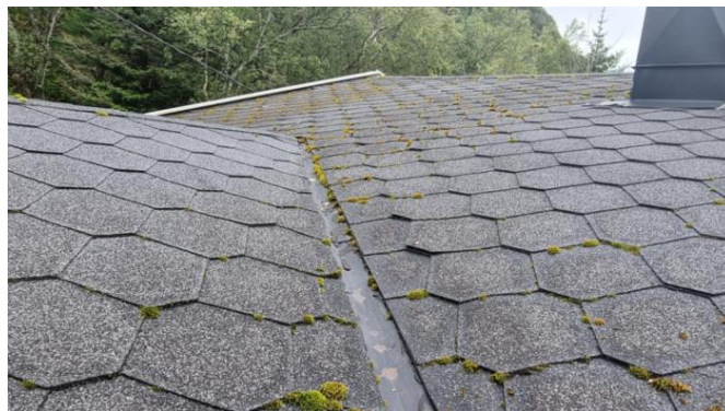
Visuell besiktelse av taket.
