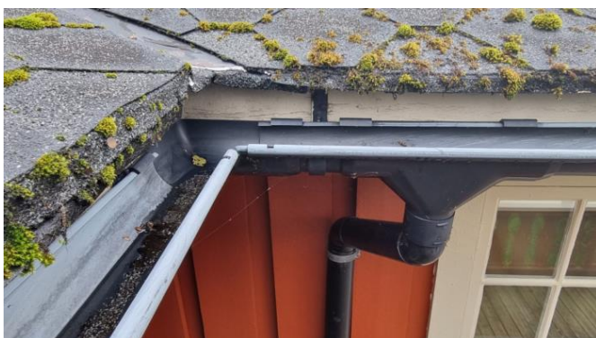
Kontroll av renner og nedløp.
