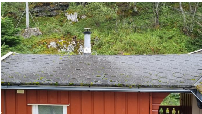
Visuell besiktelse av taket.
