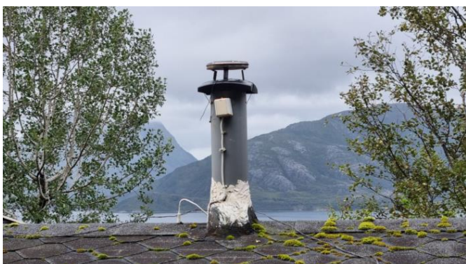
Lufting over tak.
