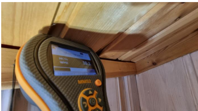
Fuktmåling i himling i stue/kjøkken, ingen unormale fuktverdier ble registrert her.
