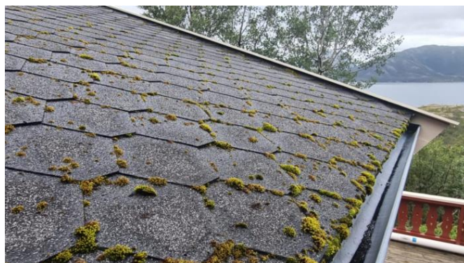
Visuell besiktelse av taket.
