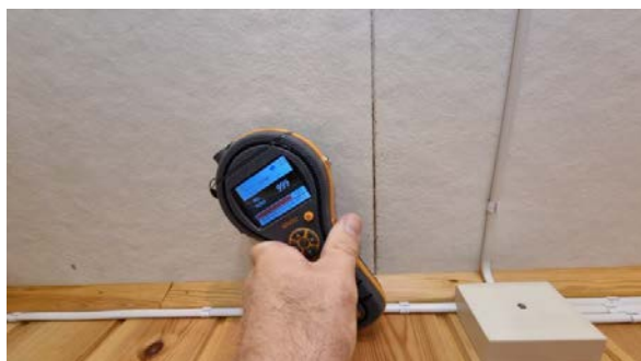
Fuktmåling i himling i bod i tilbygget del.
