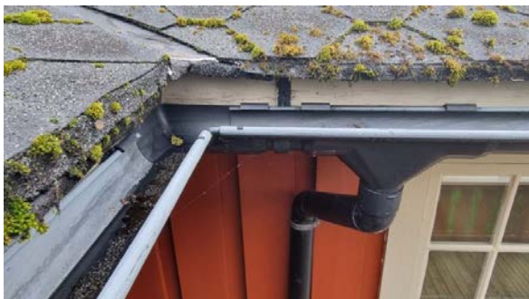
Kontroll av renner og nedløp.
