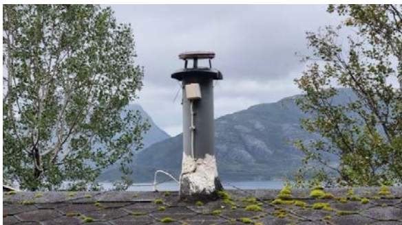
Lufting over tak.
