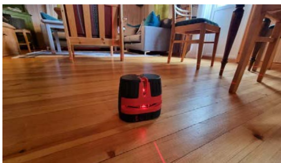
Kontroll av retningsavvik og skjevheter med krysslaser.
