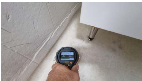
Fuktmåling i gulvet.
