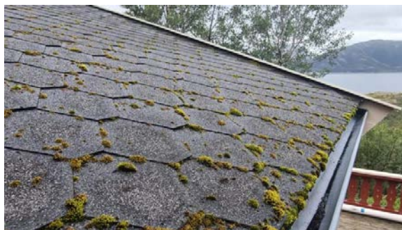
Visuell besiktelse av taket.
