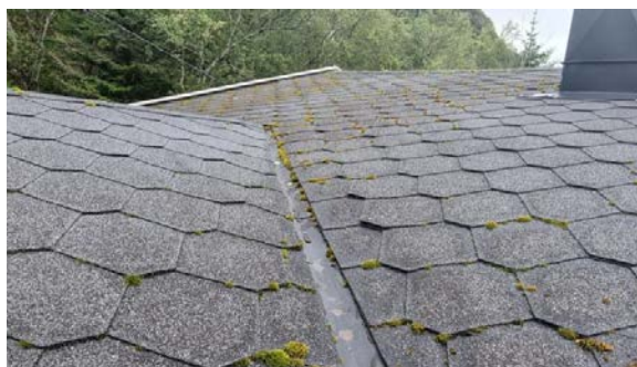
Visuell besiktelse av taket.
