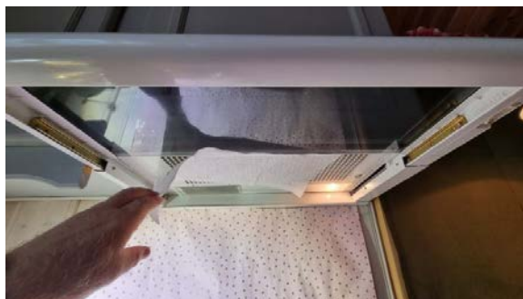
Funksjonstesting av det mekaniske avtrekket over komfyren.
