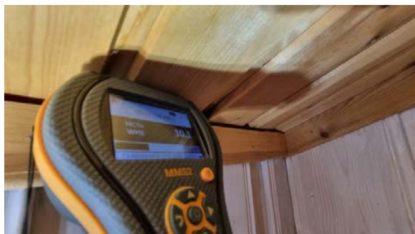
Fuktmåling i himling i stue/kjøkken, ingen unormale fuktverdier ble registrert her.
