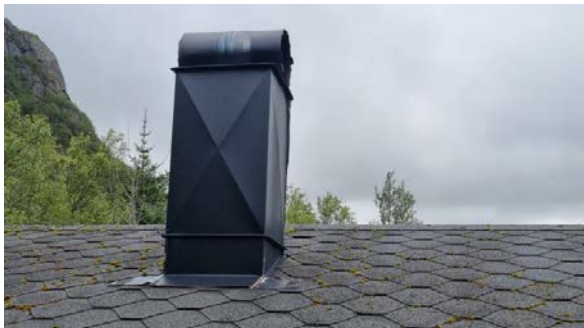
Kontroll av pipebeslag.
