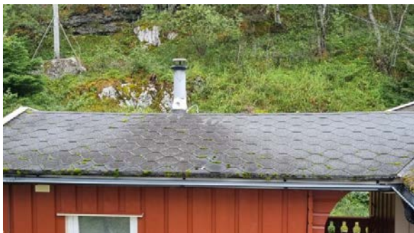
Visuell besiktelse av taket.
