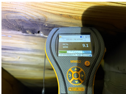
Stedvis misfarginger i taktroet uten å måle forhøyde fuktverdier.
