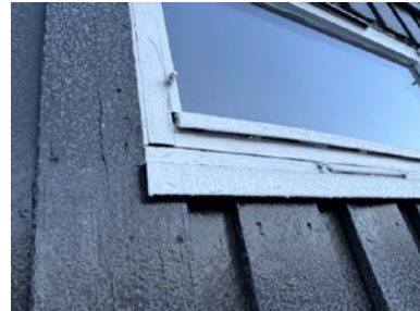
Synlige sprekkeformasjoner.
