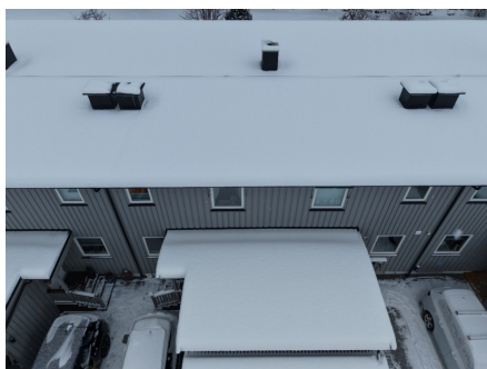
Taktekking var snødekt befaringsdagen
