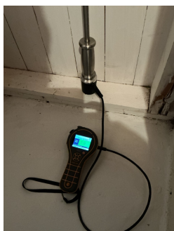
Fuktmåling i bunnsvill i delevegg.
