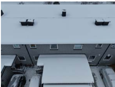
Taktekking var snødekt befaringsdagen
