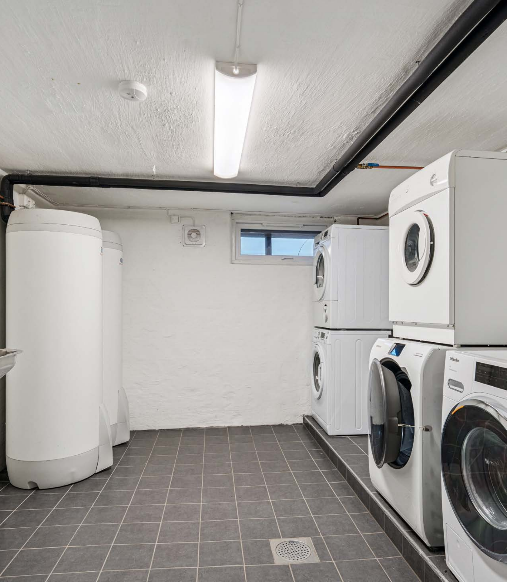
Felles vaskerom i kjeller med eget opplegg til vaskemaskin. Rommet ble pusset opp i forbindelse med baderomsrehabilitering i 2018.
