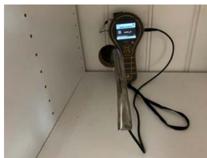
Hulltaking i kjøkkenskap
