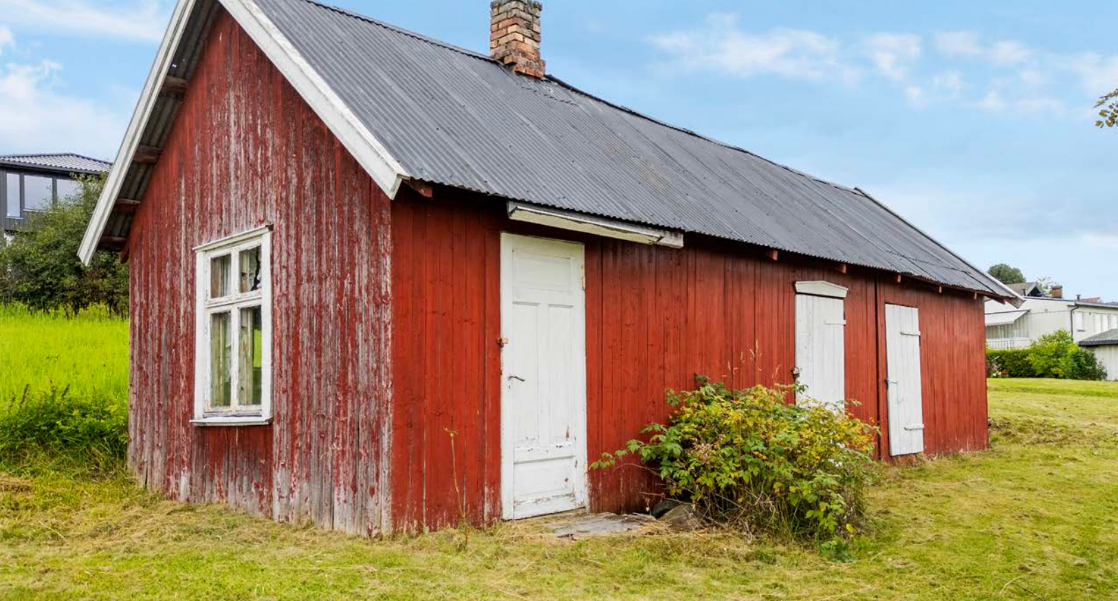
Uthus på eiendommen.
