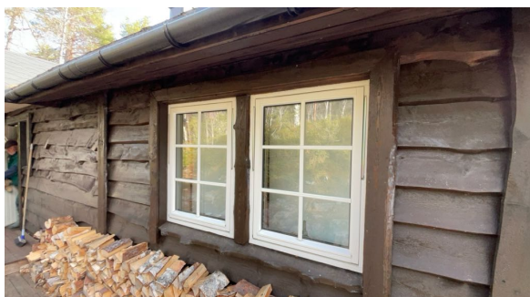
Vinduer på stue
