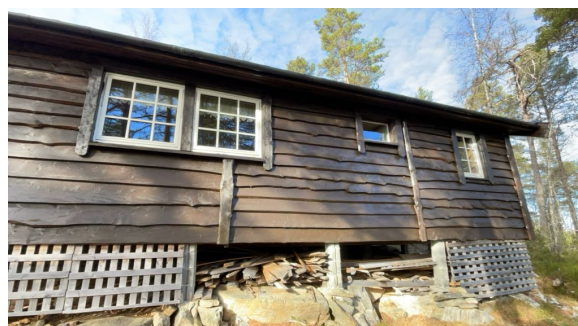
Vinduer på kjøkken, bod/teknisk rom og soverom
