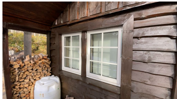
Vinduer på stue
