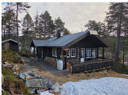
Solcellepanelet er montert opp mot møne
