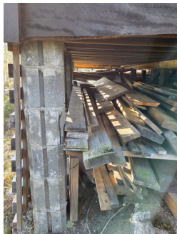
Det er noe synlig skjevhet på enkelte pilarer
