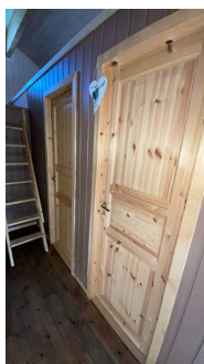
Dør til soverom 2 og teknisk rom
