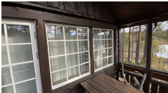
Vinduer på stue
