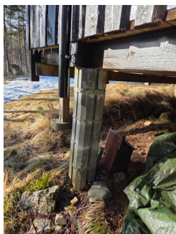
Det er noe synlig skjevhet på enkelte pilarer
