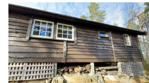
Vinduer på kjøkken, bod/teknisk rom og soverom
