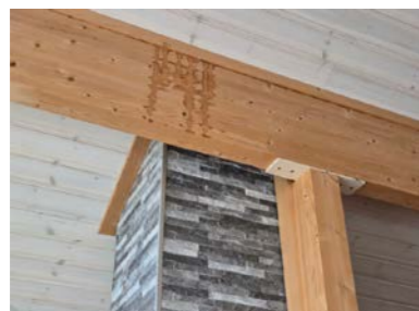
Synlig fuktmerker på drager. Selger opplyser at dette er merker fra byggeår og at disse ikke har endret seg siden
