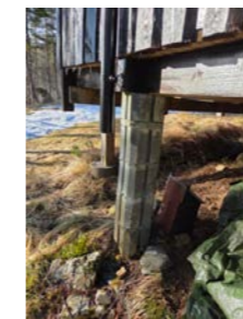
Det er noe synlig skjevhet på enkelte pilarer
