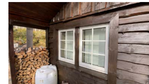
Vinduer på stue
