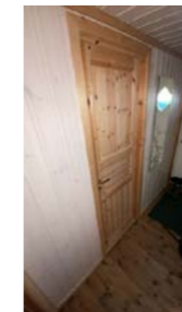
Dør til vaskerom/omklingsrom sett fra vindfang.
