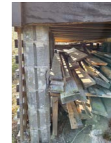
Det er noe synlig skjevhet på enkelte pilarer
