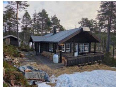
Solcellepanelet er montert opp mot møne
