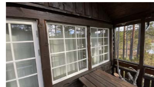
Vinduer på stue
