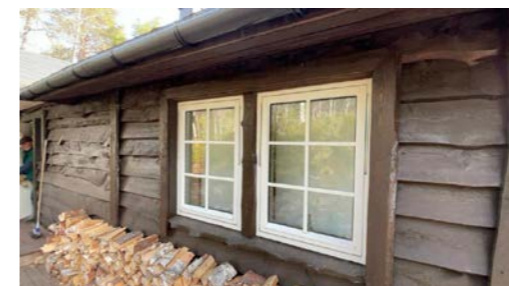
Vinduer på stue
