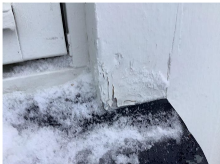
Omramming er ført helt ned til vannbrett.
