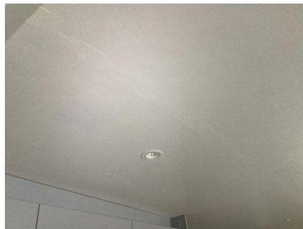
Grov utførelse av sparkel i himling.
