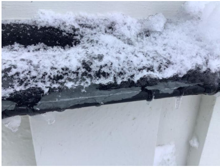
Eksempel på løsnets behandling på vannbrettbeslag.
