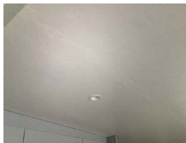
Grov utførelse av sparkel i himling.
