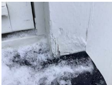
Omramming er ført helt ned til vannbrett.
