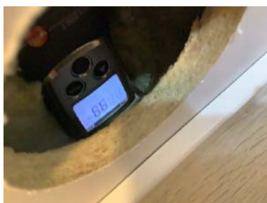
Hulltaking i innredet del, og det måles tørt.
