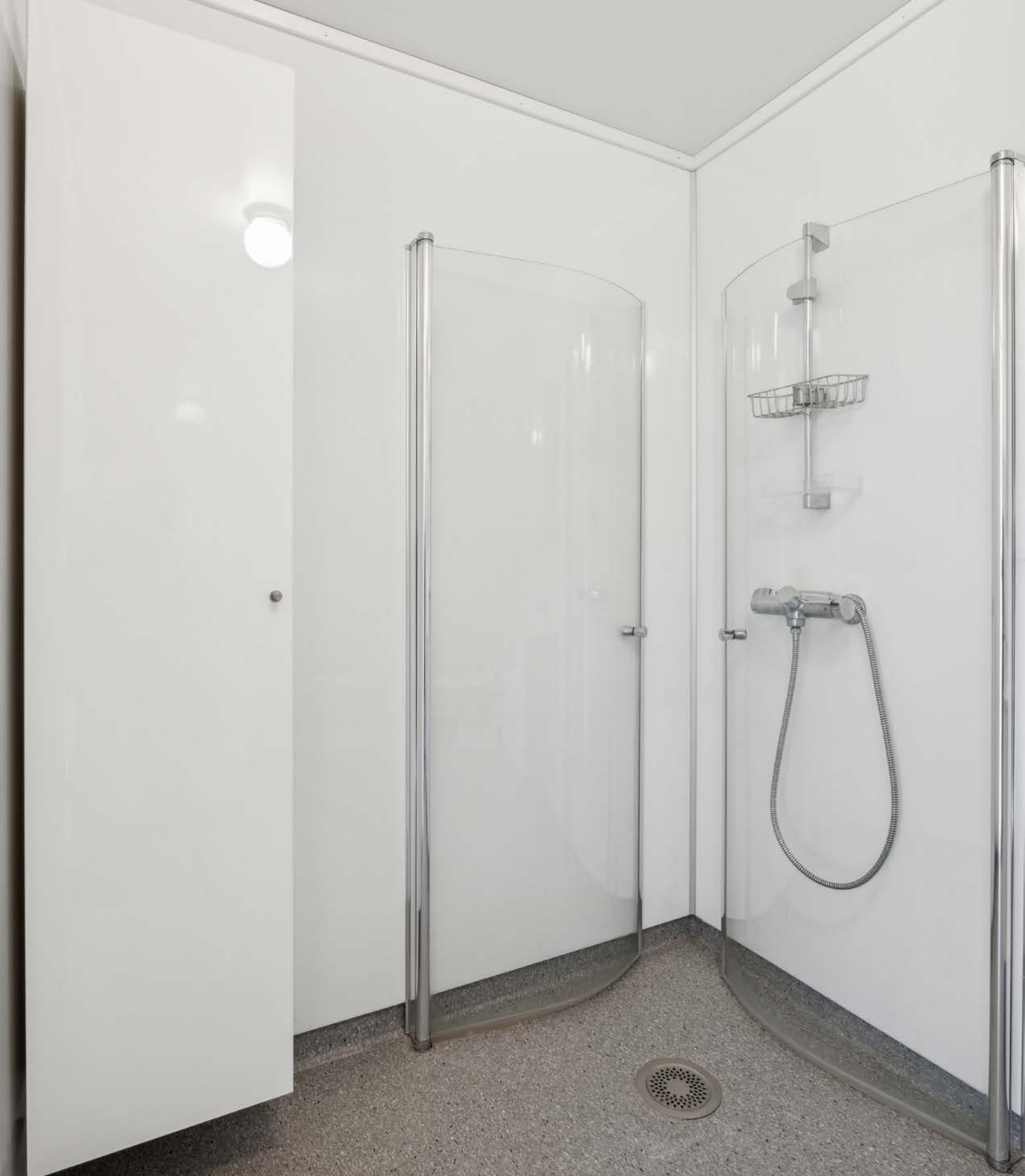
Dusjhjørne med innfellbare dører og vegghengt dusjbatteri. Badet har også et veggskap og opplegg for vaskemaskin og tørketrommel.
