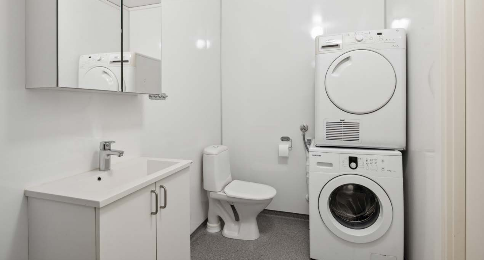
Lyst bad med belegg på gulvet og baderomsplater på veggene. I gulvet er det elektriske varmekabler.
