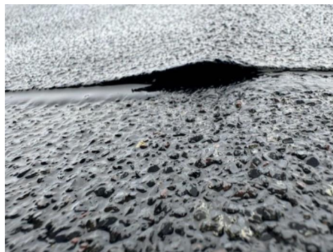
Viser hull/glippe i skjøt.
