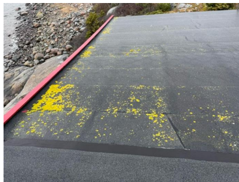
Viser hull/glippe i skjøt.
