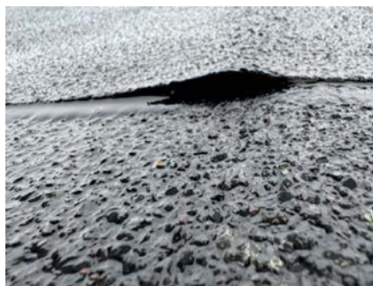
Viser hull/glippe i skjøt.
