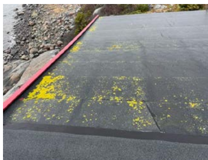
Viser hull/glippe i skjøt.
