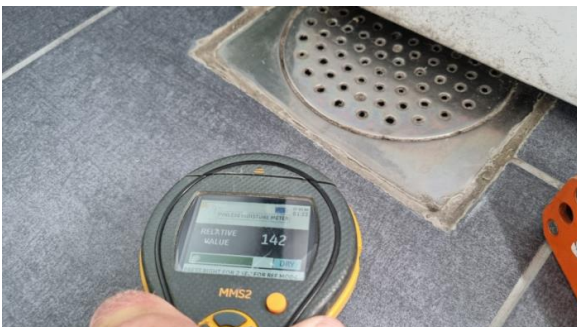
Fuktmåling i gulvet.
