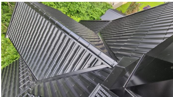
Visuell besiktelse av taket.
