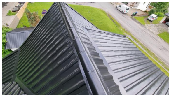
Visuell besiktelse av taket.
