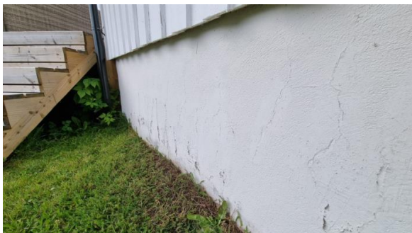
Kontroll av utvendige grunnmurer.
