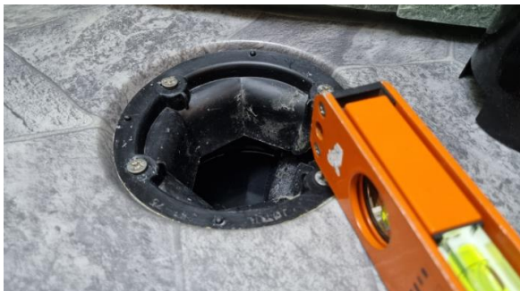
Kontroll av sluk.
