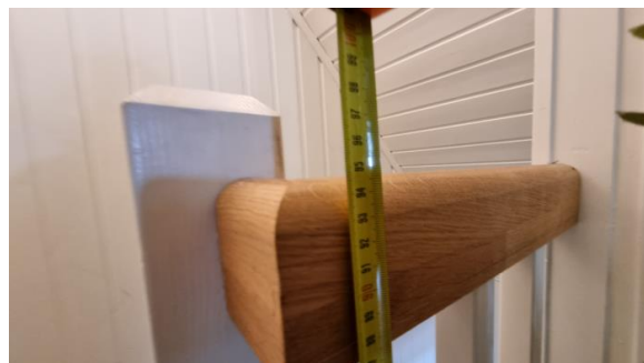
Måling av høyden på rekkverk og gelender.
