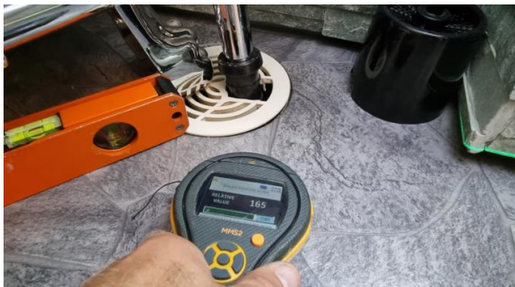
Fuktmåling i gulvet.
