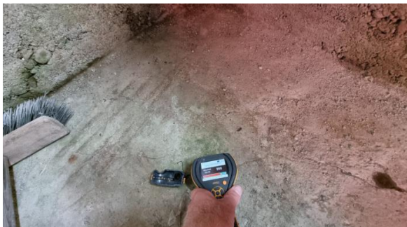
Fuktmåling i gulvet.
