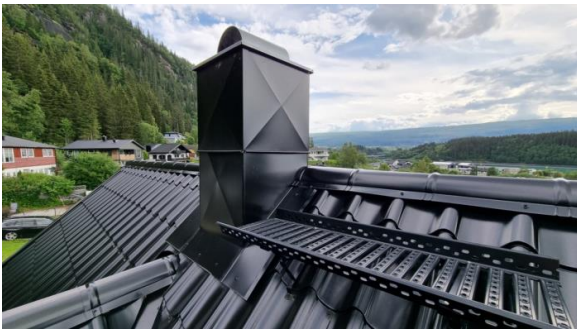
Kontroll av pipen over tak.
