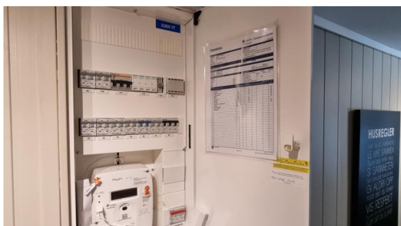
Kontroll av el-skapet.
