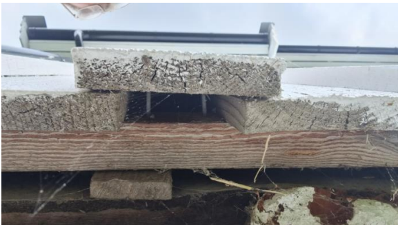
Kontroll av ytterkledningen.
