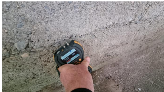
Fuktmåling i vegger.
