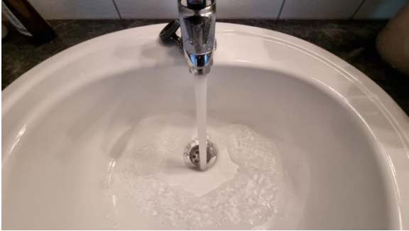
Kontroll av vanntrykk og avrenning.
