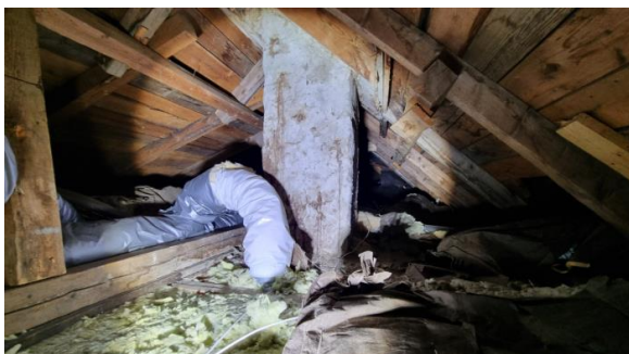
Inspeksjon av kaldloftet.
