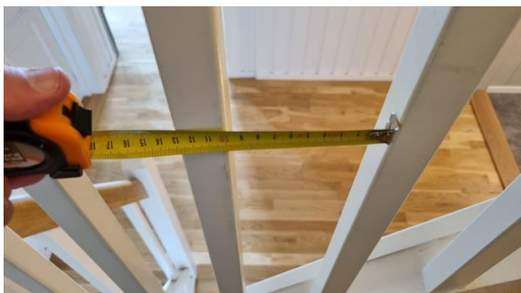
Måling av lysåpninger i gelender.
