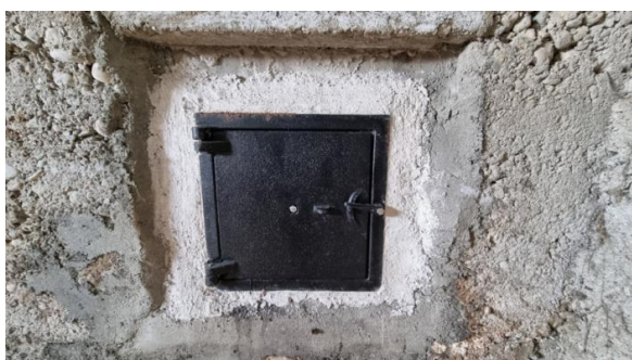
Kontroll av sotluken.
