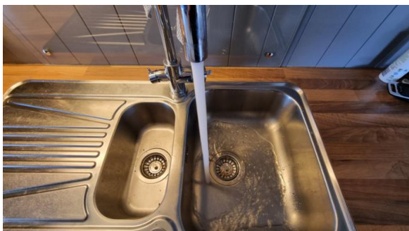
Kontroll av vanntrykk og avrenning.
