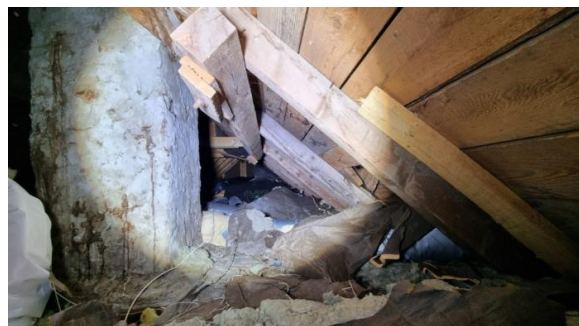
Inspeksjon av kaldloftet.
