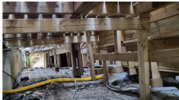
Kontroll av fundamenteringen under terrassen.
