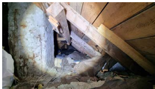
Inspeksjon av kaldloftet.
