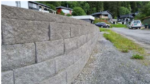
Forstøtningsmur av betongstein.
