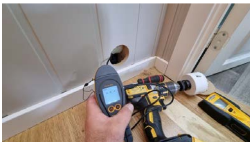
Hulltaking utført fra tilstøtende gang.
