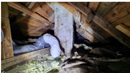
Inspeksjon av kaldloftet.
