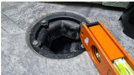
Kontroll av sluk.
