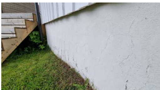
Kontroll av utvendige grunnmurer.
