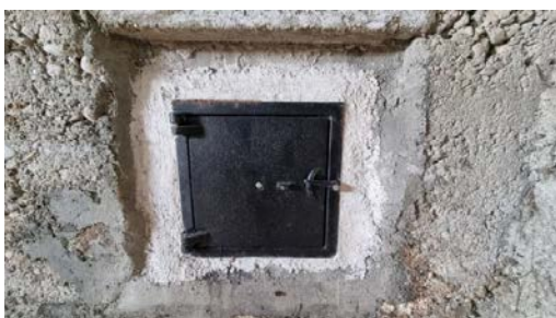
Kontroll av sotluken.
