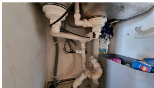
Kontroll av røropplegg under oppvaskkummen.
