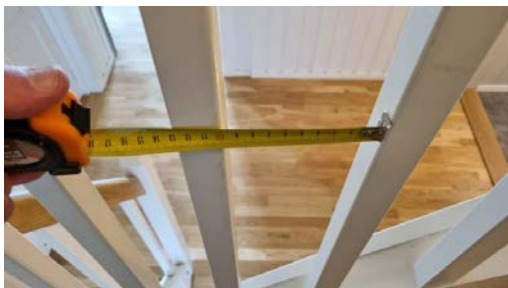
Måling av lysåpninger i gelender.
