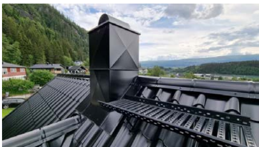
Kontroll av pipen over tak.
