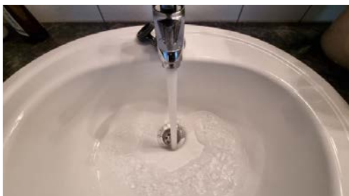
Kontroll av vanntrykk og avrenning.
