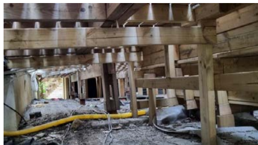
Kontroll av fundamenteringen under terrassen.
