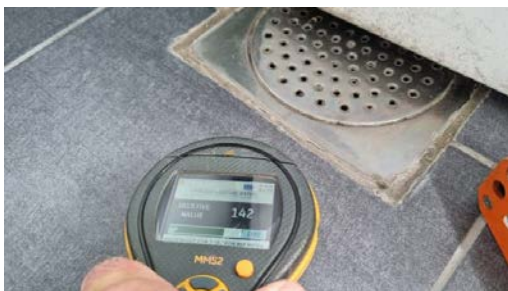
Fuktmåling i gulvet.
