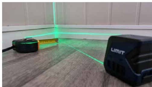
Kontroll av planavvik/ skjevheter i gulv.
