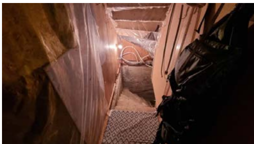
Trapp mellom hovedetasje og kjelleretasje.
