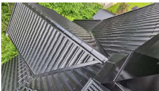
Visuell besiktelse av taket.
