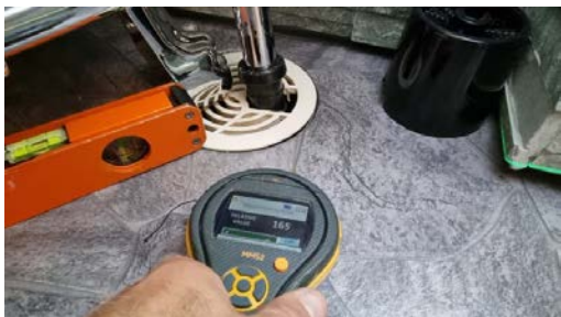
Fuktmåling i gulvet.
