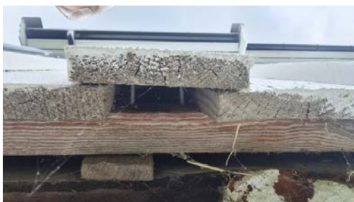
Kontroll av ytterkledningen.
