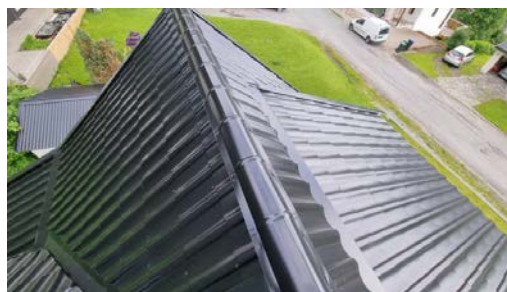
Visuell besiktelse av taket.
