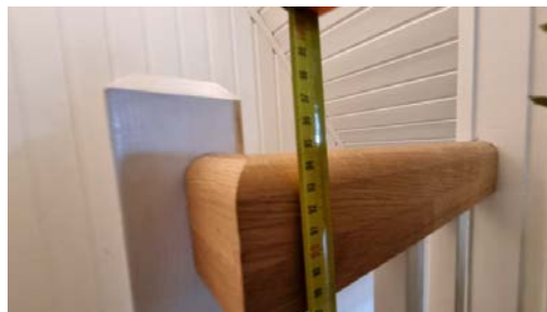
Måling av høyden på rekkverk og gelender.
