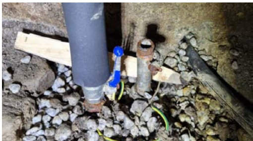
Kontroll av innvendig hovedstoppekran.
