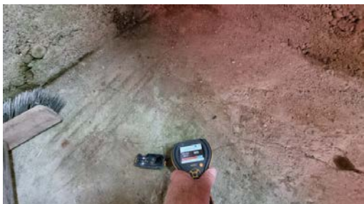
Fuktmåling i gulvet.
