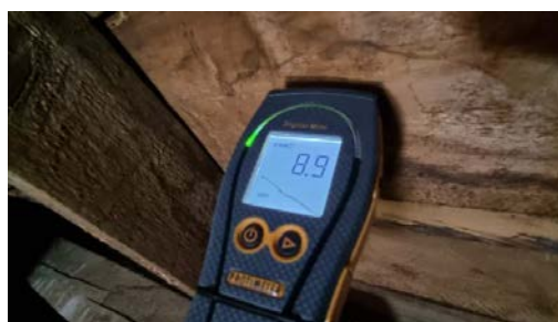
Fuktmåling i takkonstruksjonen på kaldloftet, ingen unormale fuktverdier ble registrert.
