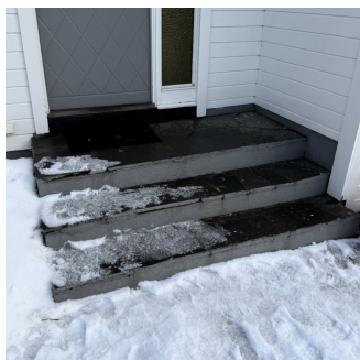
Platting/trapp på sørveggen.
