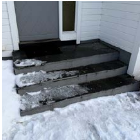
Platting/trapp på sørveggen.
