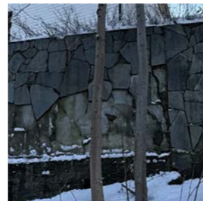
Manglede skifer og vertikal sprekk mot nord
