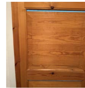
Dør inn til vaskerom gliper i speilene.
