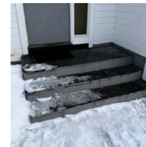
Platting/trapp på sørveggen.
