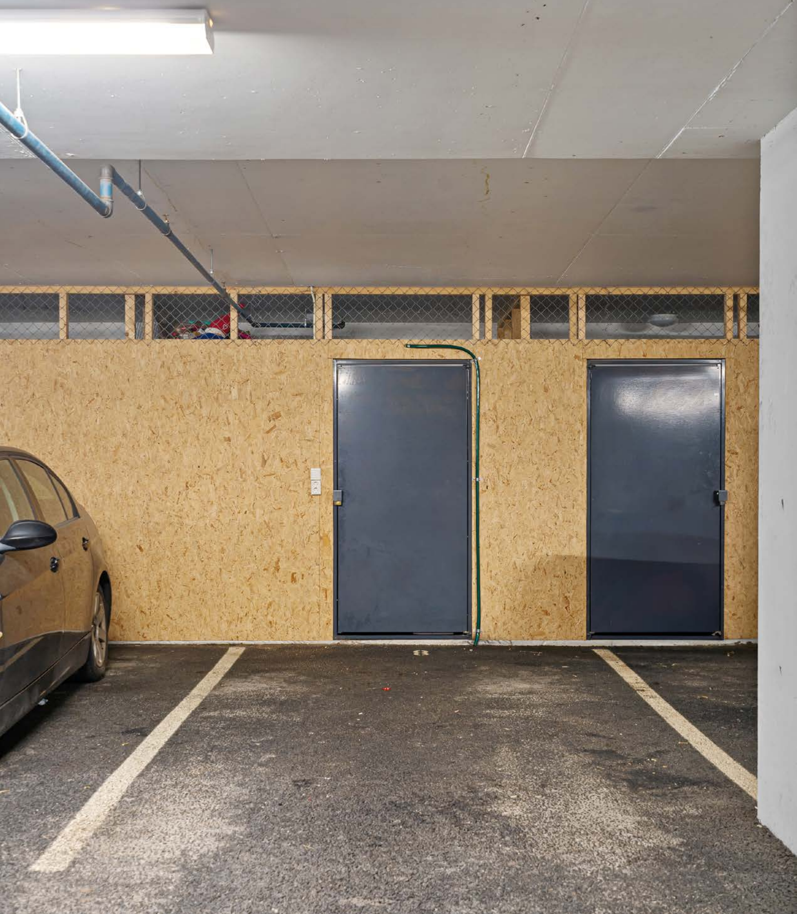
Parkering i lukket garasjeanlegg med tilhørende bod i bakkant. Mulighet for el-bil lader
