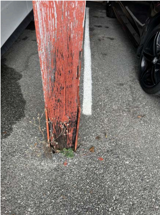
Mangelfull utførelse der treverk går ned til terreng. Mangler søylesko eller tilsvarende.
