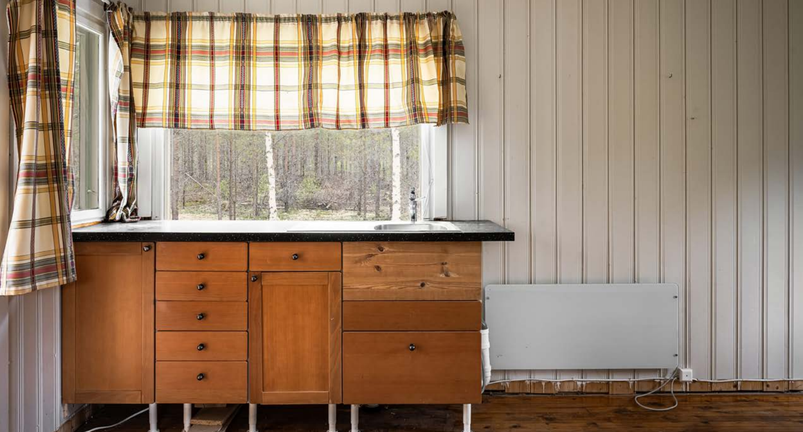
Kjøkkeninnredning er delvis er flyttet til annen del i rommet.
