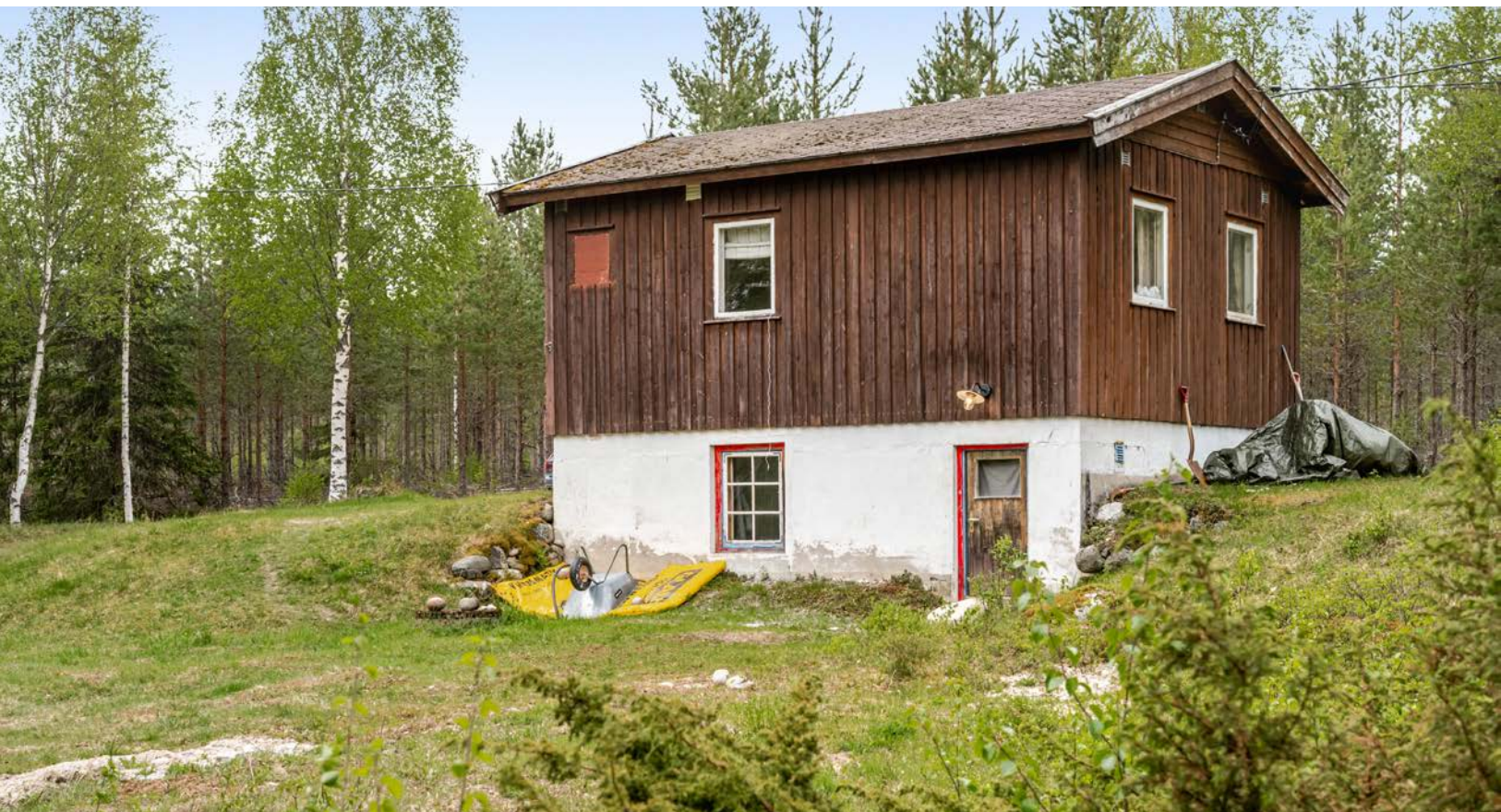
Utvendig adkomst til kjelleren som i dag er innredet med en stue, baderom og teknisk rom.
