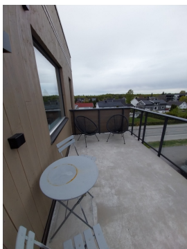
Glasset rekkverk og med laminert felt ved balkong.
