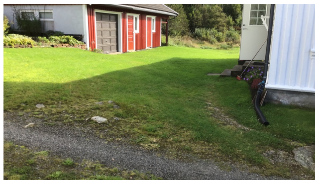
terreng skråner mot grunnmur
