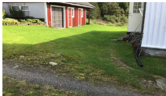
terreng skråner mot grunnmur
