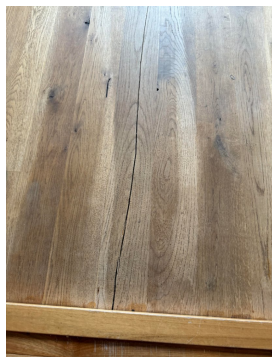
Bildet viser sprekke i gulvbord på soverom.
